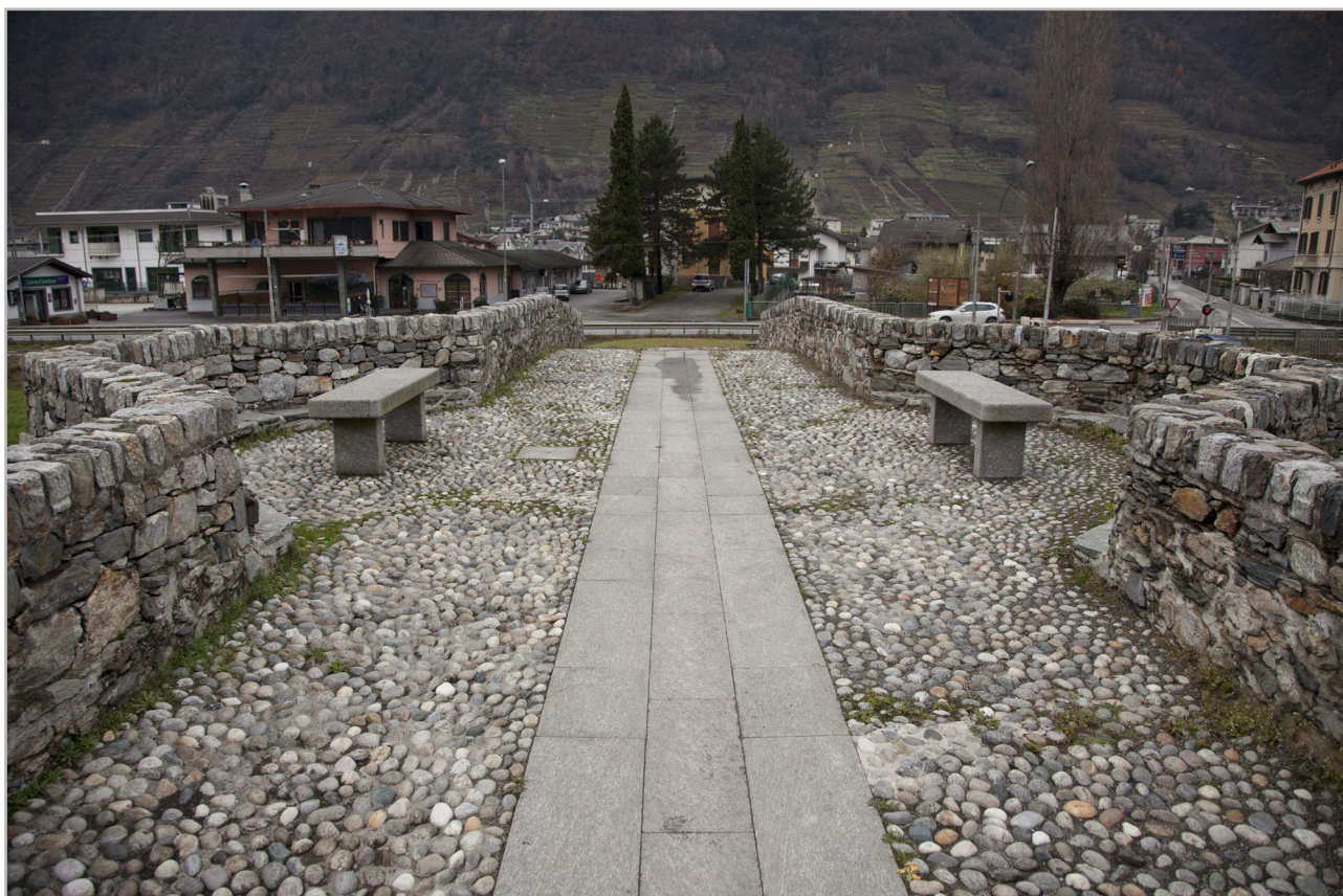
Il Ponte di Villa dopo il restauro (foto: M. Brigatti)
